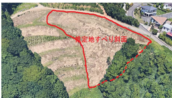
写真7 Google(写真5)の当該盛土における 推定地すべり斜面
