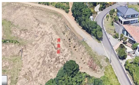
写真6 Google Earth 3D 写真における 当該盛土の滑落崖 (段差は1 m以上と推定)
